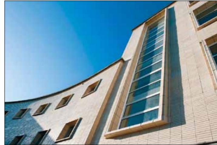
Nicht nur auf architektonische Details wie zum Beispiel die Rekonstruktion der Fensterlaibungen wurde Wert gelegt. Nach schlimmen Erfahrungen mit Betonaggressivität stand allen voran die Frostsicherheit der Fassadenbekleidung als gesetzte Qualitätsanforderung im Fokus.
