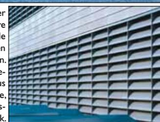
Grauton vorgegeben, der dann speziell für dieses Objekt entwickelt wurde. Diese vorgehängte, wärme gedämmte und hinterlüftete Fassade dient, neben der Optik im Wesentlichen dem zusätzlichen Wärmeschutz.
