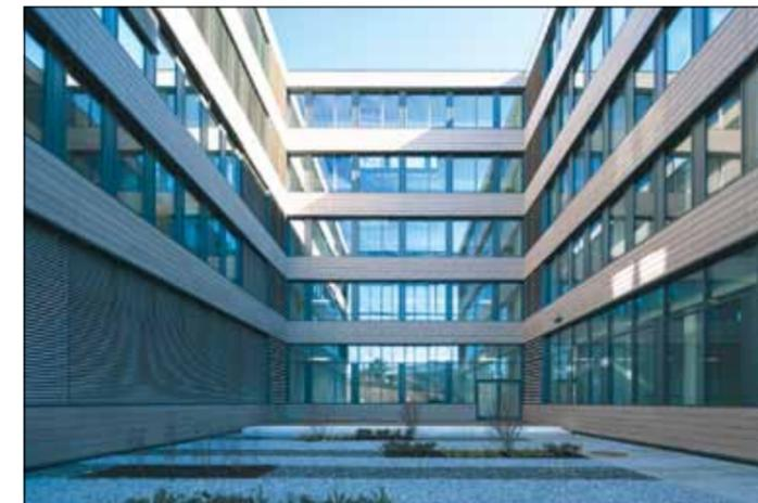
An den der Sonneneinstrahlung weniger ausgesetzten Flächen wurde das starre keramische Lamellensystem durch flexible Jalousien ersetzt, beispielsweise in den Innenhöfen.
