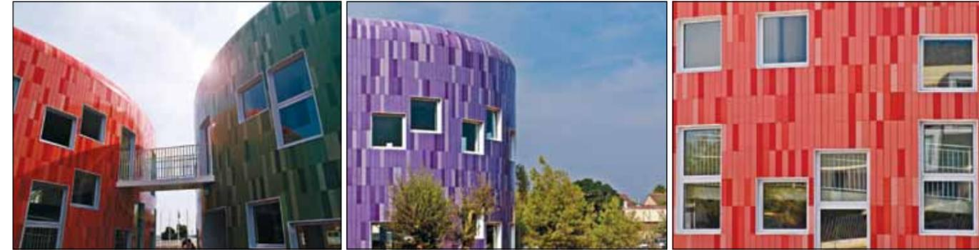
Die Fenster sind scheinbar wahllos in der runden Fassade platziert, aber so bemessen, dass sie exakt ins Raster der keramischen Platten passen
