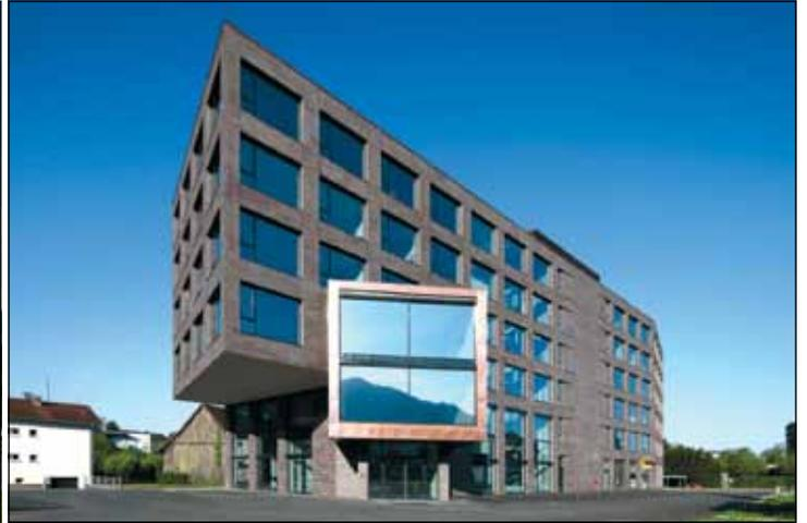
Als spezieller Objektauftrag wurden 2 600 m<sup>2</sup> Riemchen und 5 000 Winkel von der Serienfarbe „Metallic Schwarz“ in Bezug auf das Farbverhältnis von Schwarz- und Braunanteilen modifiziert. Denn über allem stand der Wunsch nach einer ursprünglich und wertig anmutenden Fassade mit leicht archaischem Charakter.
