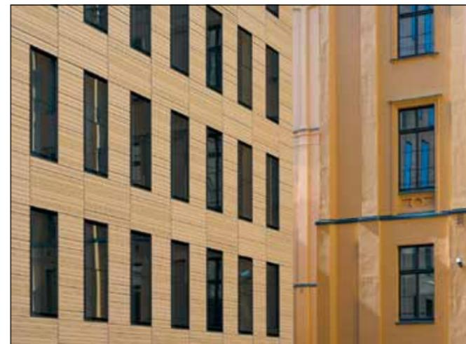
Die Fassade aus profilierten Keramikplatten orientiert sich in Material, Farbe und Textur an dem Bestand.
