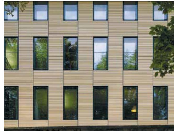
Die hoch-wärmegeämmte Fassade ist mit profilierten Keramikplatten bekleidet, die in Verbindung mit einer fassadenbündigen Verglasung die skulpturale Präsenz des Baukörpers herausstellen.
