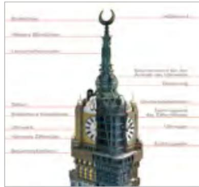
Eine schematische Darstellung der Elemente, die sich an der ca. 83000 Tonnen schweren Turmspitze befinden. Ein weiterer Superlativ: Die goldene Mondsichel an der Turmspitze ist mit einem Durchmesser von 23 Metern der größte jemals gebaute Halbmond.
