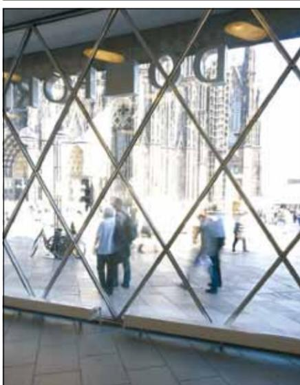
Die Idee des Architekten, den Fugenverlauf der Domplatte im Foyer des DOMFORUMs aufzugreifen, entspricht genau dem Konzept, ein offenes Forum am Dom zu sein. Die großen Glasflächen im Erdgeschoss sind durch ein rautenförmiges Netz engmaschig strukturiert und wirken wie eine Membran
