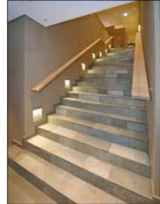
Die Treppenstufen sind mit Clarks Quarzit belegt, einem natürlich gespaltener beigefarbenen Quarzit mit einem gold-silbrigem Glanz, der in den Steinbrüchen von Clarks Basin (USA) abgebaut wird.
