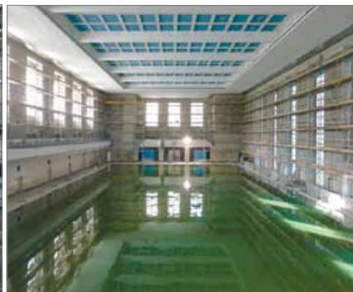
Foto links außen: Abdichtungsarbeiten in einem Sprungbecken mit dem mit Hochspannung prüfbareren Abdichtungssystem. Links: 14 Tage lang bleibt die Probefüllung im Schwimmbecken.
