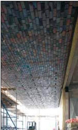
Da die Fertigteil-Dachplatten auf Teleskopen liegen, ist eine thermische Trennung und Abdichtung auch mit einer Klinker-Fertigteile-Konstruktion möglich. Auch die Deckenuntersicht wird mit Ziegelementen verkleidet (Fotos: CRH Clay Solutions)
