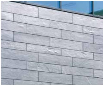
Daraus lassen sich, je nach gewähltem Format, die vielfältige horizontal und vertikal ausgerichtete Fassadenentwürfe realisieren. Die Schieferplatten mit unsichtbaren Befestigungen sind in den Natursteinfarben Anthrazit und Polargrün verfügbar. Die Schieferfassade entsteht nach dem Entwurf des Architekten in Maßfertigung. Jeder Stein ist kalibriert und vom Hersteller nach Werkskizze auf der Rückseite für den Einbau von Hinterschnittankern vorbereitet, was eine Besonderheit dieser
